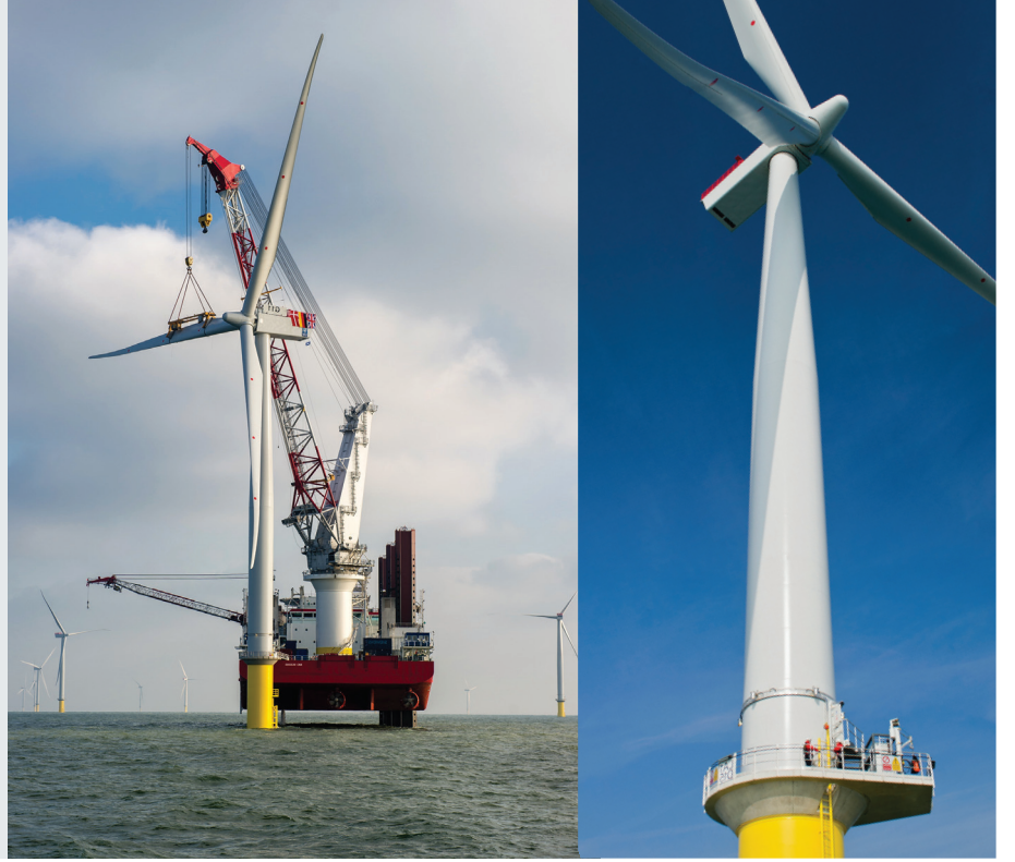
تركيب أول توربين في مصفوفة لندن - مزرعة أبراج رياح على سطح البحر تركيب آخر توربين طاقة رياح من الـ 175
